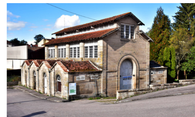
→ Photo avant travaux
