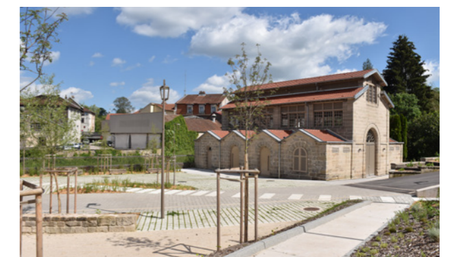
→ Photo après travaux
