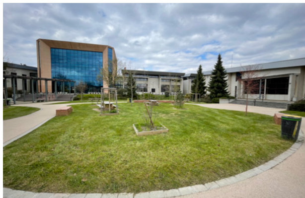
→ Cour du Lycée RUDLOFF après les travaux - Strasbourg
